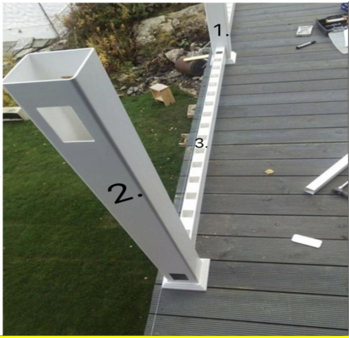
1. Tre ned på stolpe (nr 1), husk å ta på bunnkrans. Husk at bunnkrans er 14,5x14,5cm (stolpe 10x10cm) når du monterer braketten, sånn at bunnkransen ikke stikker utenfor terrassen/muren. Skru stolpen fast i braketten med 4 selvborrende skruer (4,2x32mm m/flatt hode).
